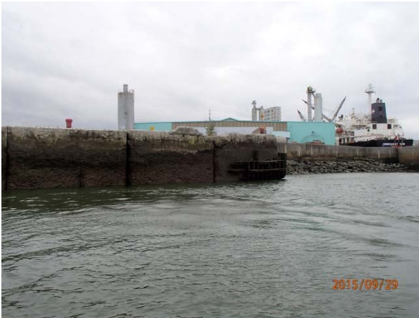
1) Aperçu partiel de la zone à l'étude
