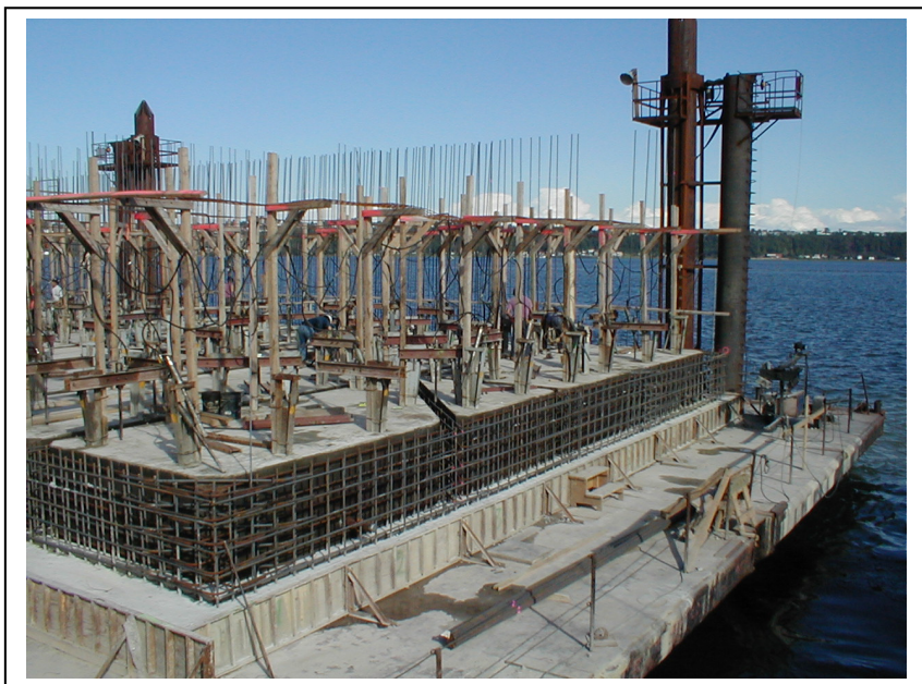
Figure 3.7 Fabrication d'un caisson sur une barge submersible
