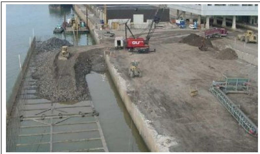
Figure 3.9 Remplissage des caissons
