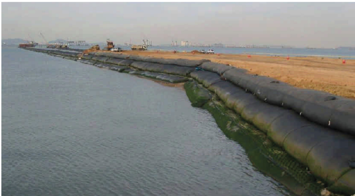
Figure 3.3 Vue partielle d'une digue en géotubes
